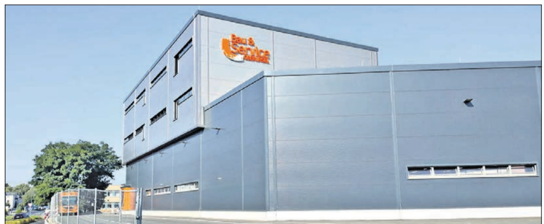
Wichtig mit Farbklecks: Der BSO-Neubau an der Ludwig-Erhard-Straße. Fotos: js
