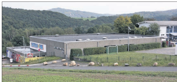
Rund 500 000 Euro kostet die Sanierung der Comenius-Halle.
