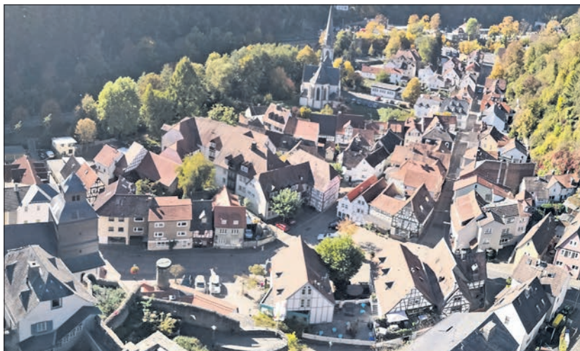
Für Eppsteins Altstadt – hier eine Aufnahme vom Bergfried aus auf Gottfriedplatz, Wernerplatz und die westliche Burgstraße – gibt es eine Landesförderung, um die Innenstadt attraktiver zu gestalten. Foto: Stadt Eppstein
