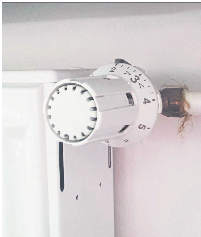
Thermostatventil auf Stufe zwei.
