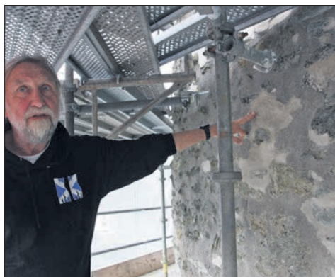
Joachim Zeune zeigt die Stellen, an denen das Mauerwerk bereits mit Kalkmörtel ausgebessert wurde. Foto: Beate Schuchard-Palmert
