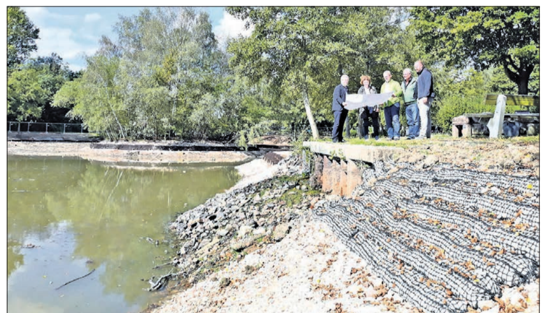
Der Wiederaufbau beginnt, das Wasser läuft ein, die Planer sind auf der Ziellinie: Der Maasgrundweiher wird ökologisch optimiert. Auf dem Foto erkennt man den pyramidenartigen Aufbau der Uferanbefestigung. Foto: js
