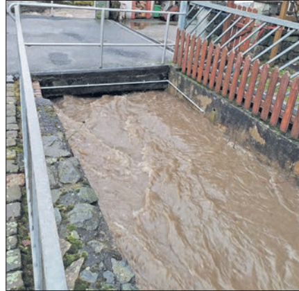
Im Januar staute sich das Wasser des Silberbachs an der Brücke Am Brühl.
