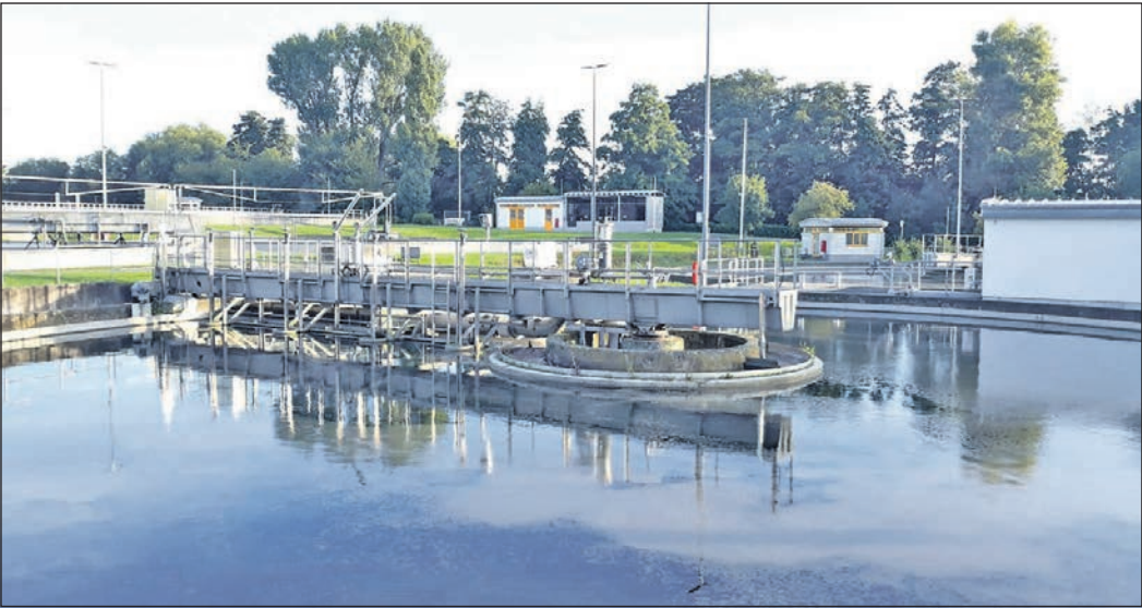
Das Klärwerk nahe der Krebsmühle wird erneut aufgrund gesetzlicher Vorgaben zum Millionenfresser. Wie die anstehende Aufrüstung finanziert wird, ist noch unklar. Foto: js
