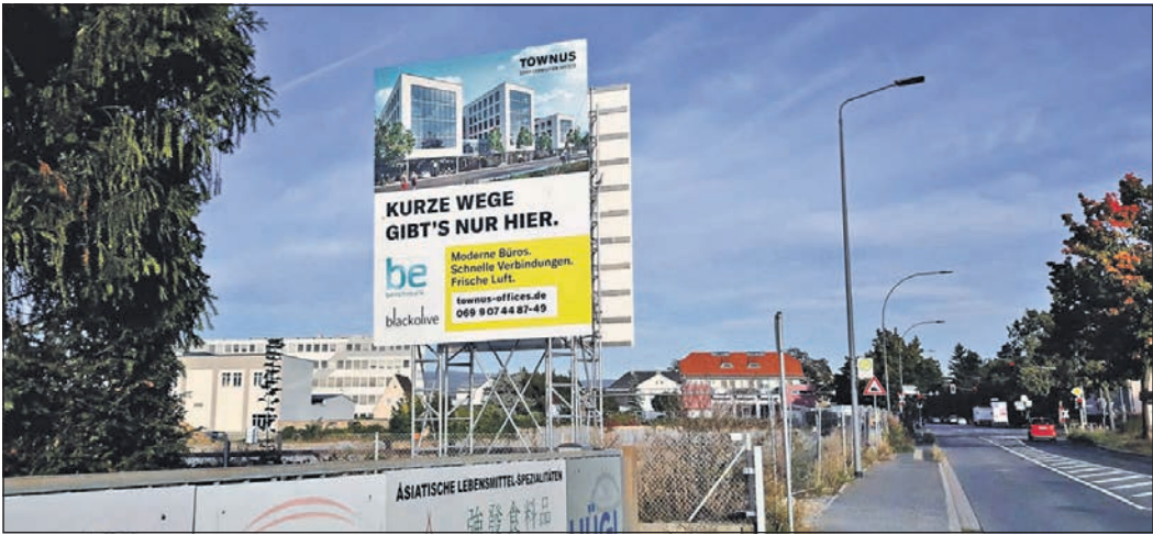
Das Projekt „TOWNUS“ ist ein Beispiel für die lahrende Ansiedlung von Firmen und Gewerbe. Seit Jahren wird über das Projekt an der Frankfurter Landstraße auf dem einstigen MKW-Gelände geredet, noch immer steht das Wasser in den Baugruben. Foto: js
