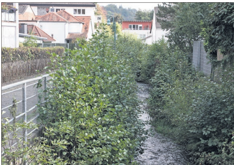
Die Büsche entlang des Dattenbachs zwischen Am Bündelberg und Taunusstraße wurden seit einigen Jahren nicht zurückgeschnitten. Foto: jp
