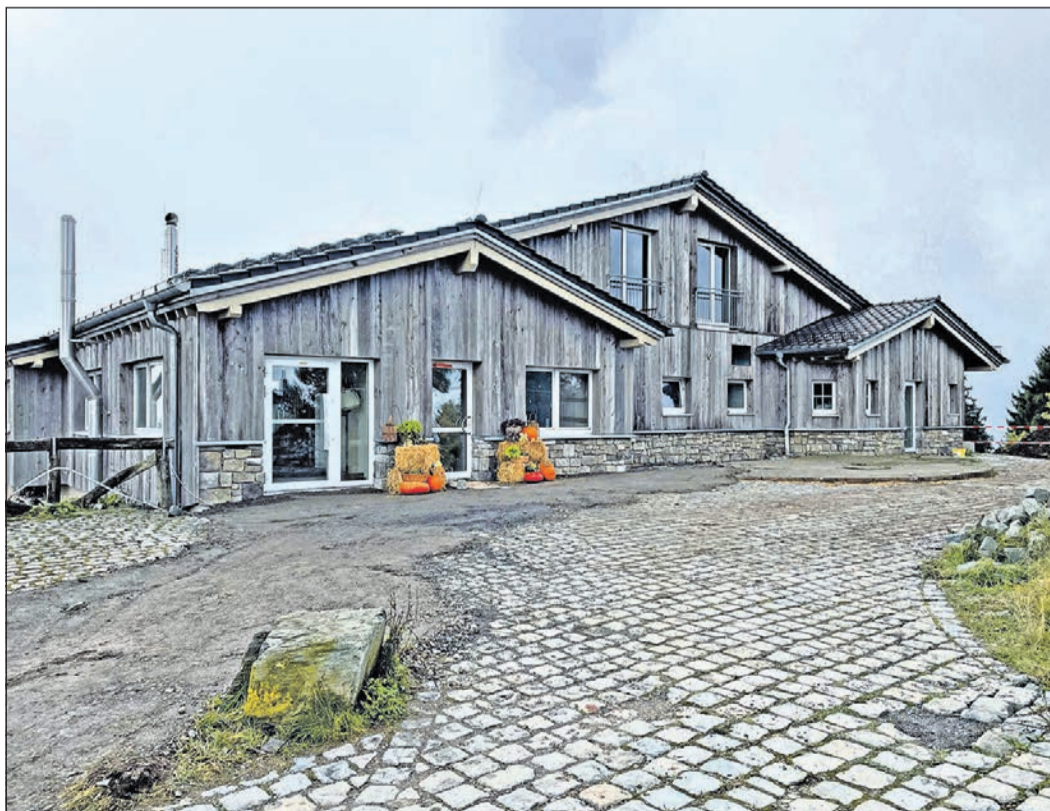
Die neue Fassade nimmt Bezug auf die Bauzeit des alten Feldberghauses um 1840.
