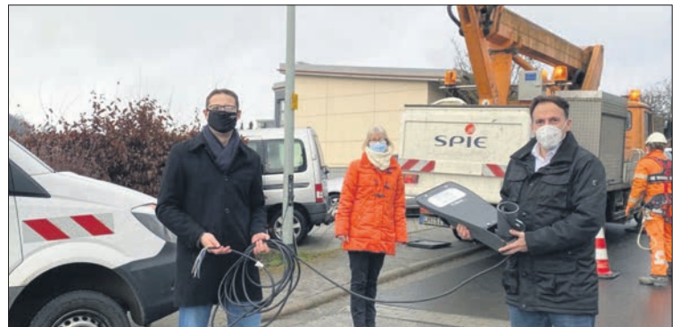
Florian Bienias, Kommunalbeauftragter der Süwag, Niederjosbachs Ortsvorsteherin Andrea Sehr und Bürgermeister Alexander Simon bei der Umrüstung des ersten Abschnitts in Niederjosbach im Dezember 2020.
