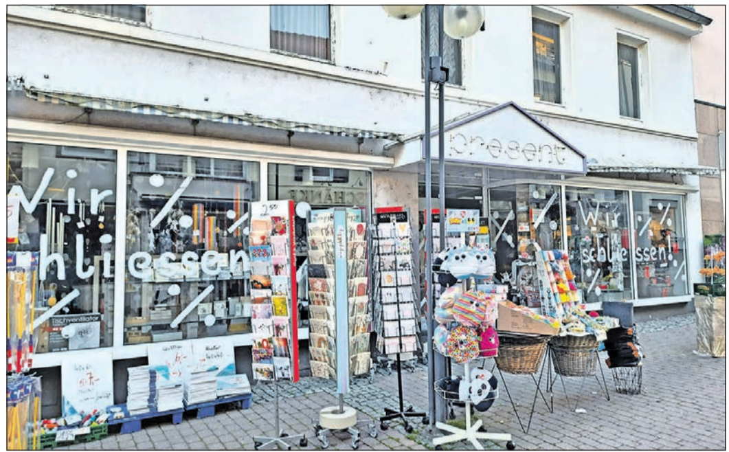
Am 30. Oktober schließt Present in der Vorstadt für immer. Das Gebäude wird abgerissen und durch einen Neubau ersetzt. Foto: gt.
