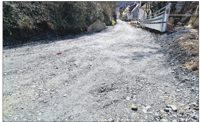
Der untere Teil der Gimbacher Straße während des ersten Bauabschnitts Anfang 2021. Foto: Stadt Eppstein
