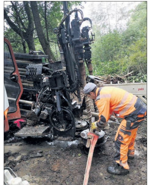
Arbeiten mit Spezialgeräten zur Verlegung einer neuen Spülleitung. Foto: Stadt Eppstein
