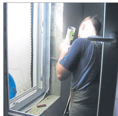
Montageschaum reicht beim Einbau neuer Fenster nicht aus – der Rahmen muss luftdicht in der Leibung verklebt werden. (Foto: VZ RLP)
