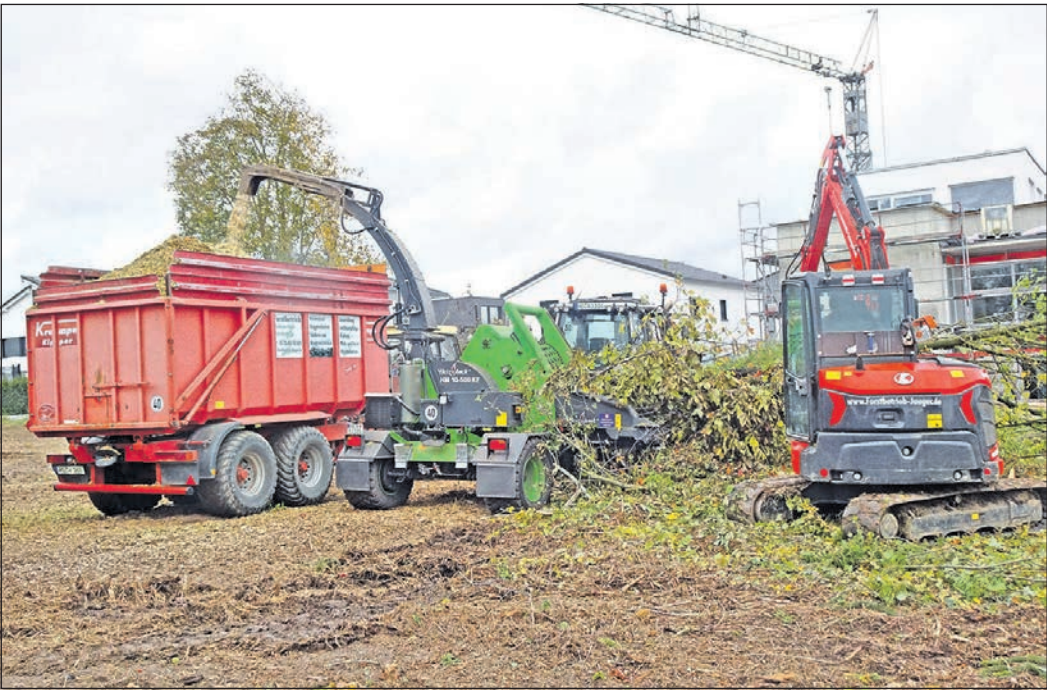
Mit dem Häcksler wird das Gelände gerodet, auf dem bald gebaut werden soll. Fotos: HB
