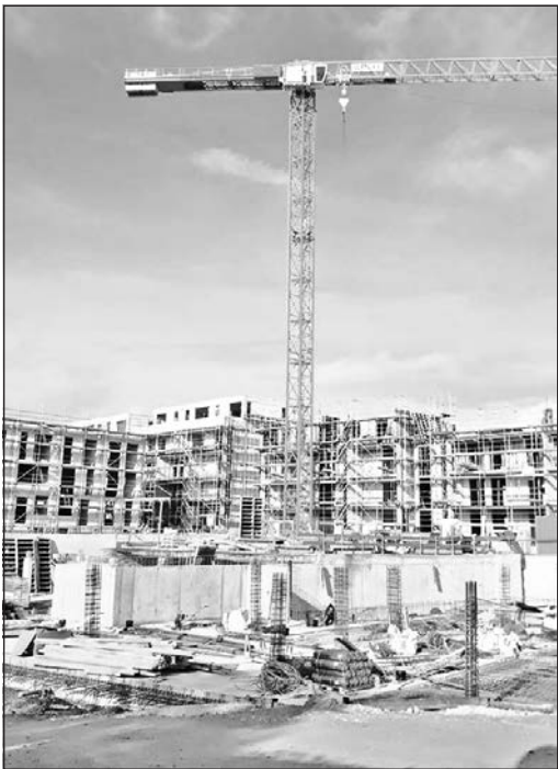
Auf dem ehemaligen Vickers-Gelände wachsen die Kräne in den Himmel und die Geschossbauten in die Höhe. Hier will die Stadt für mehrere Millionen Euro Wohnraum zur Weitervermietung erwerben. Foto: js
