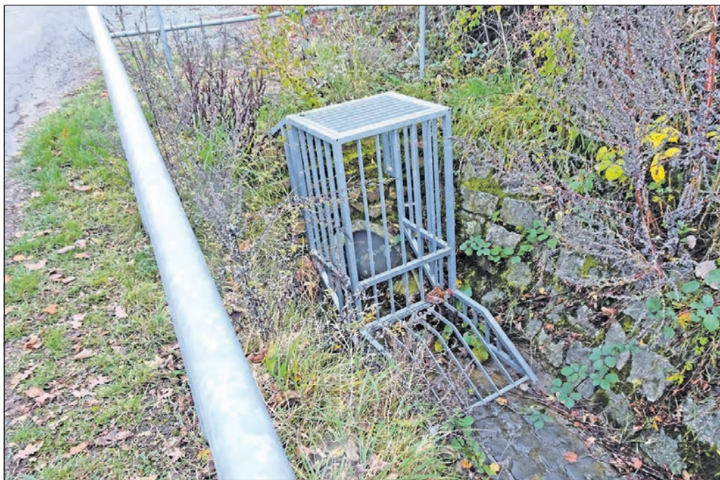
Das Fanggitter im Flutgraben an der Waldstraße soll verhindern, dass der Zulauf zum Abfluss verstopft wird. Foto: HB
