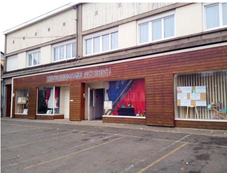
Gebäude von außen
