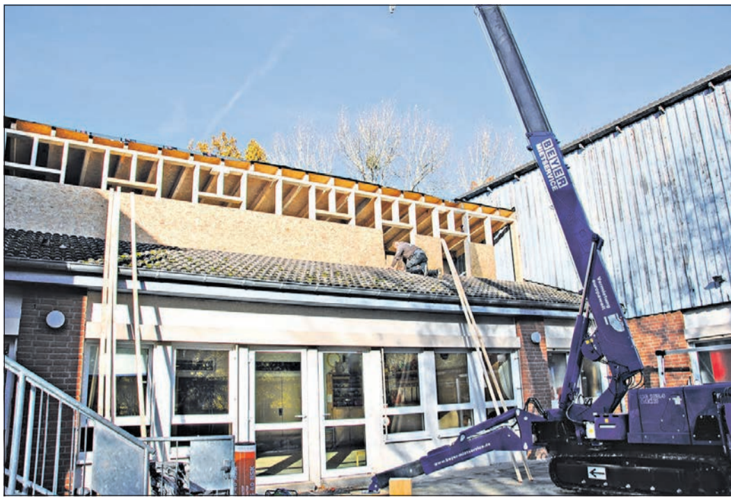
Die Zimmerleute der Firma Pehl aus Bad Soden kümmern sich um die Einhausung des Balkons, der in neue Kita-Gruppenräume in der Badener Straße verwandelt wird. Foto: Stadt
