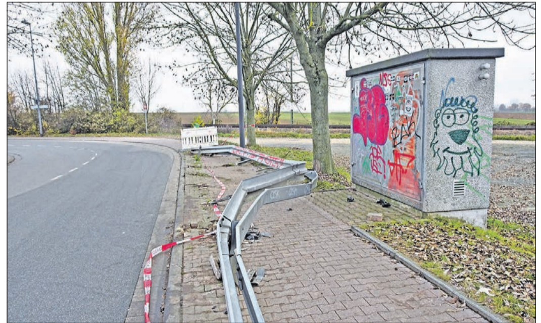
An der Unfallstelle in der Industriestraße ist die Leitplanke demoliert, aber der Kasten mit dem Gasdruckregler unverseht. Foto: HB
