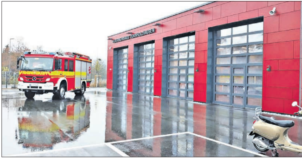
Das neue Feuerwehrhaus in Dornholzhausen, in das bisher 6,1 Millionen Euro investiert wurden, soll im Februar in Betrieb genommen werden. Foto: js
