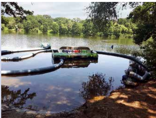
Die Zirkulationsanlage während der Installation. Foto: ASV Gräfenhausen
