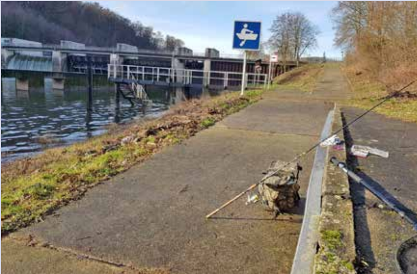
Die Staustufe bei Wahnhausen
