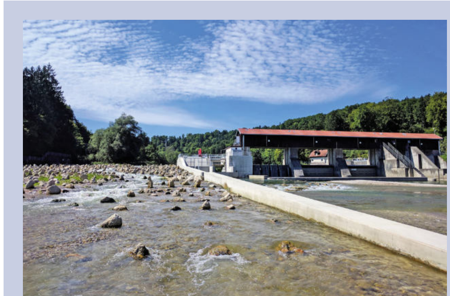
Die Fischpassage am Kraftwerk Baierbrunn (Isar) wird von 70 % der abwandernden Fische angenommen. Was nicht unbedingt berauschend klingt, ist das einzige Positivbeispiel einer umfangreichen Untersuchung.
