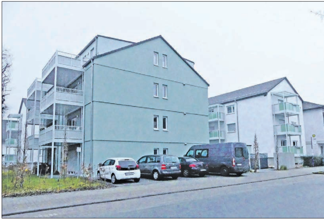
Der Neubau in der Bommersheimer Straße fügt sich harmonisch in den sanierten und in den gleichen Farben gestalteten Altbestand ein. Foto: bg
