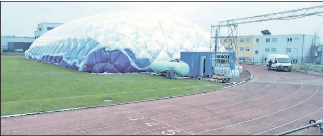
Weich gelandet auf dem Boden der EKS-Sportfelder: Binnen eines Tages haben die Spezialisten aus Berlin die Traglufthalle auf dem Sportgelände hinter den gesperrten Hallen aufgebaut. Bis zum Abend war auch genügend Luft unter das Hallendach gepumpt. Foto: js
