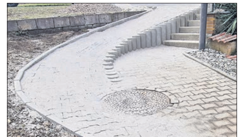
Neue Rampe entlang eines Fußweges in der Hainbuchenstraße in Bremthal.
