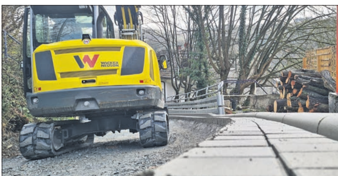
Beim Straßenbau in der engen Gimbacher Straße in Eppstein kommt es auf Timing und Genauigkeit an.
