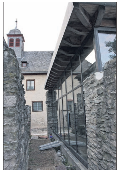
Der Vereinsraum in der „Juchhe“ der Burg soll endlich fertig gebaut werden. Foto: EZ-Archiv
