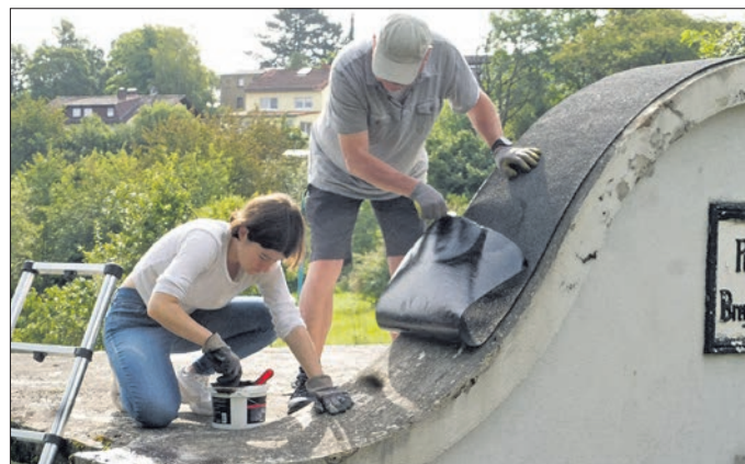
Stadtverordnete Lisa Heidenreich und Ortsbeiratsmitglied Hans Jörg Schmidt verlegen eine Bitumenmatte zum Schutz auf den Deckbogen des alten Pumpenhauses. Foto: privat
