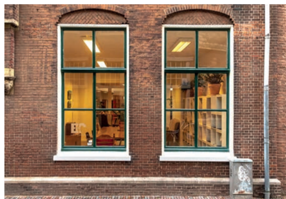
Moderne Vakuum-Isoliergläser sind so schlank wie ein Zweifach-Isolierglas, dämmen aber mehr als doppelt so viel Wärme und schützen gleichzeitig effektiv vor dem Straßenlärm. Durch die Erhaltung der Rahmen und Profile ist der Isolierglas-Tausch zudem besonders umweltfreundlich und nachhaltig. Foto: Fineo/akz-o
