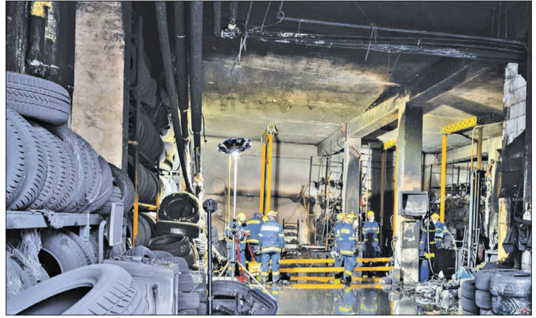
Ein Blick in die ausgebrannte Autowerkstatt mit Reifenlager am Tag danach: THW und Feuerwehr sind bis in die Nachmittagsstunden des Neujahrstags mit den Nachlöscharbeiten und Sicherungsarbeiten am Gebäude beschäftigt. Foto: Sajak
