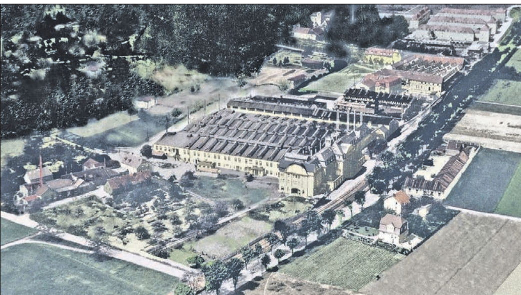
Eine Luftaufnahme der Motorenfabrik Oberursel aus dem Jahr 1928 gibt Einblick in alte Zeiten (kolorierte Aufnahme, GKMO). Fotos: Historischer Verein Rhein-Main-Taunus
