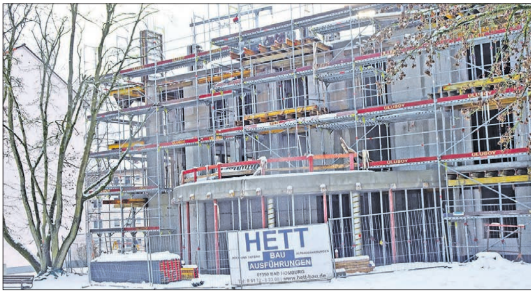
Noch steht hier eine Baustelle, doch schon bald soll Richtfest gefeiert werden. Der Neubau des Volks-, Bau- und Sparvereins (VBS) im Hessenring wird künftig Seniorenwohnungen, eine Tagespflege der Caritas sowie ein Café beherbergen. Foto: HB
