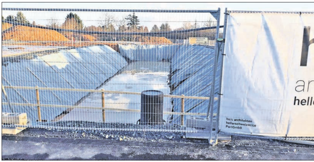
Die Baugrube ist ausgehoben, hier entsteht in der verlängerten Ebertstraße das Hauptgebäude des Instituts für Bienenkunde. Foto: js
