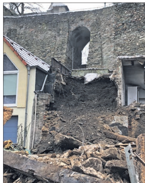
Das Abbruchgebäude Burgstraße 60 liegt unterhalb der Mauer des Ostaufgangs. Deshalb suchte das Landesdenkmalamt nach historischen Spuren.
