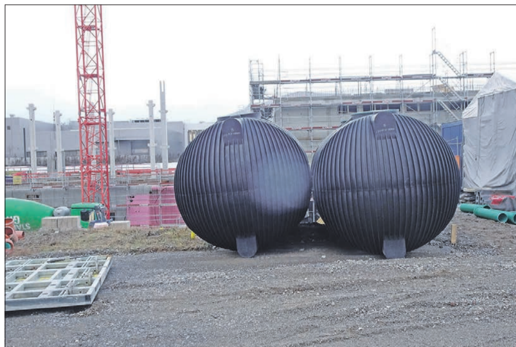
Schwarze Versorgungstanks am Rande der Baugrube. Foto: HB
