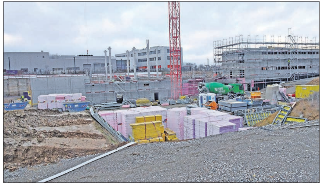
Die Baustelle von der Bahnstraße aus gesehen. Die künftige Logistikhalle wird bereits durch Stützpfiler markiert. Foto: HB
