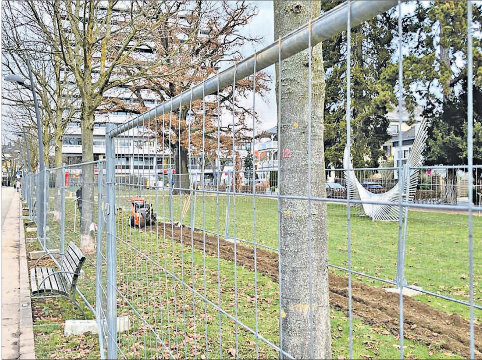
Der doppelte Zaun beherrscht mindestens die nächsten vier Wochen das Bild vom Park in der Adenauerallee, zwischen den Drahtelementen ist die gebaggerte Furche erkennbar, in die 40 Zentimeter tief das Rohrleitungssystem zur Bewässerung der Kastanien verlegt wird. Foto: ach
