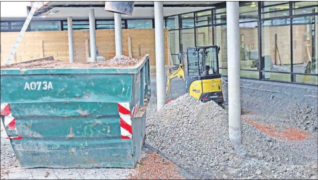
Der Ausbau an der Geschwister-Scholl-Schule hat begonnen. Unter der Pausenhalle im Innenhof kommt bereits der Bagger zum Einsatz. Foto: HB
