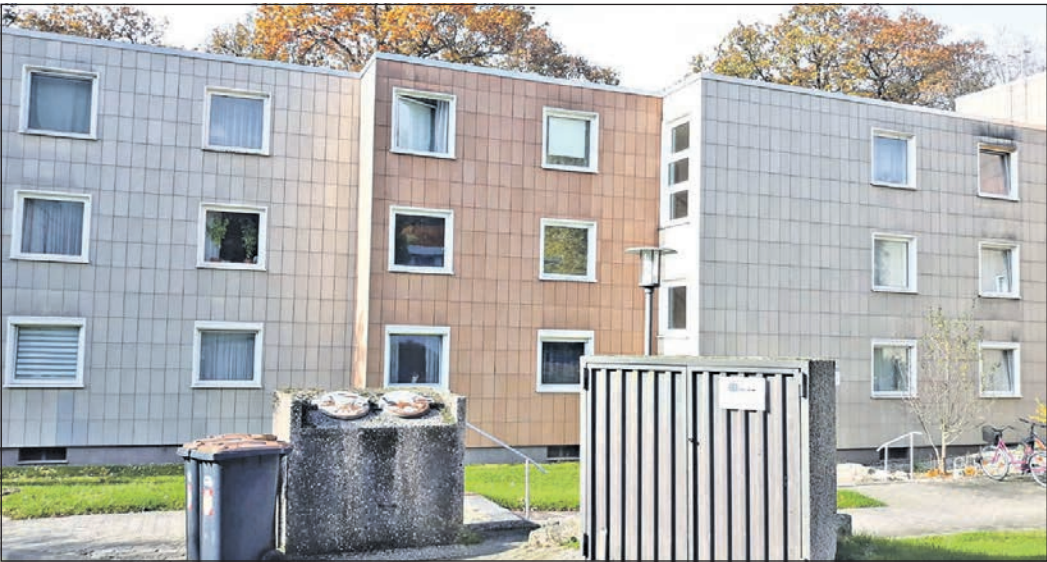
Blick auf einen Teil der Personalwohnungen, die zur Reha-Klinik der Deutschen Rentenversicherung gehören. Der Leerstand wächst, viele Wohnungen sind nicht mehr belegt. Foto: js
