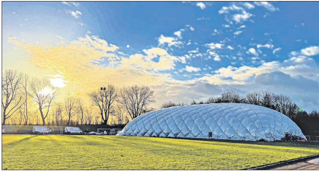
Der Innenausbau im „gelandeten Raumschiff“ an der IGS hat begonnen, in vier bis sechs Wochen machen die Handwerker Platz für die Sportler. Foto: Hochtaunuskreis
