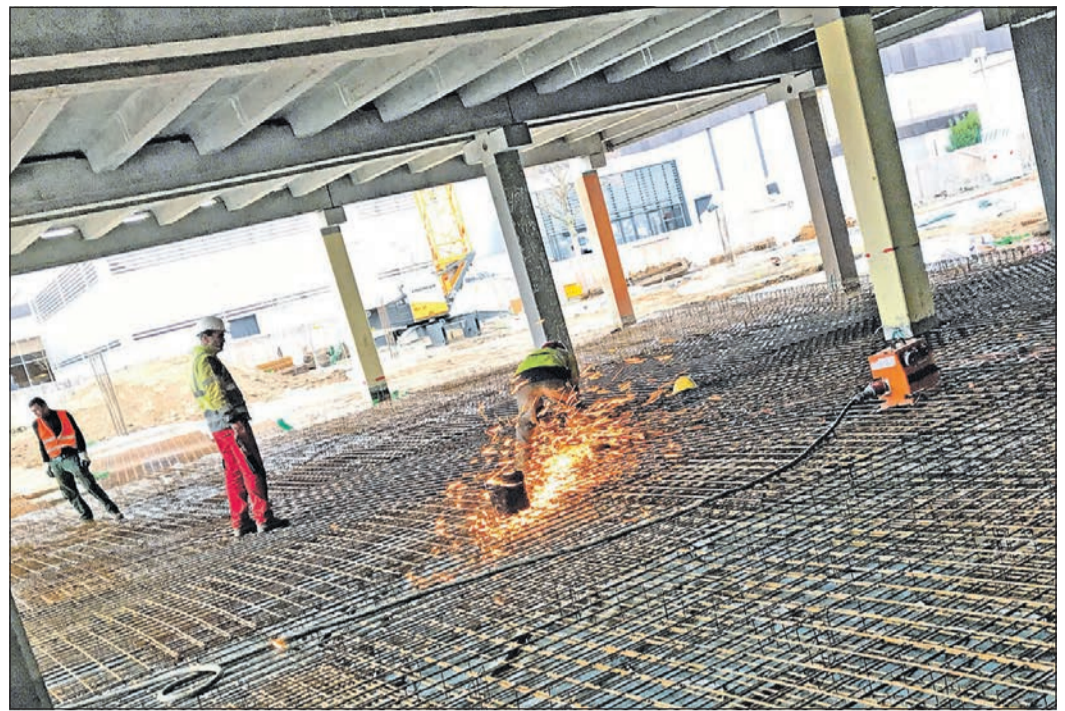
1,8 Millionen hat der Main-Taunus-Kreis für Schulbauprojekte bewilligt. Bauarbeiten bei laufenden Großprojekten haben auch bereits in der Vergangenheit an der Main-Taunus-Schule stattgefunden, wie zu sehen ist. Foto: Main-Taunus-Kreis
