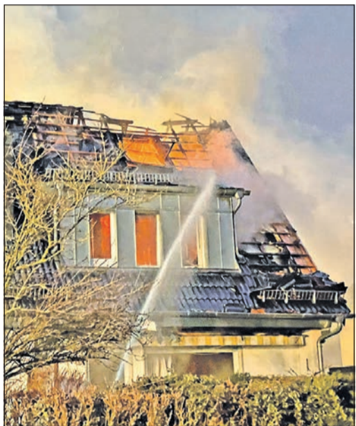
Trotz des massiven Löschangriffs brennt es in dem oberen Geschoss des Wohnhauses lichterloh. Foto: Feuerwehr Oberursel
