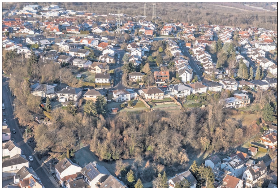
Verwilderte Gärten mitten in Bremthal haben sich zum unerwarteten Refugium für Vögel und Fledermäuse entwickelt. Dort sollen neue Einfamilienhäuser gebaut werden. Foto: Ulrich Häfner
