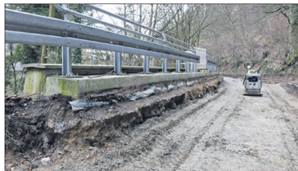
Der Untergrund der Gimbacher Straße wird vorbereitet. Foto: Jochen Haupt
