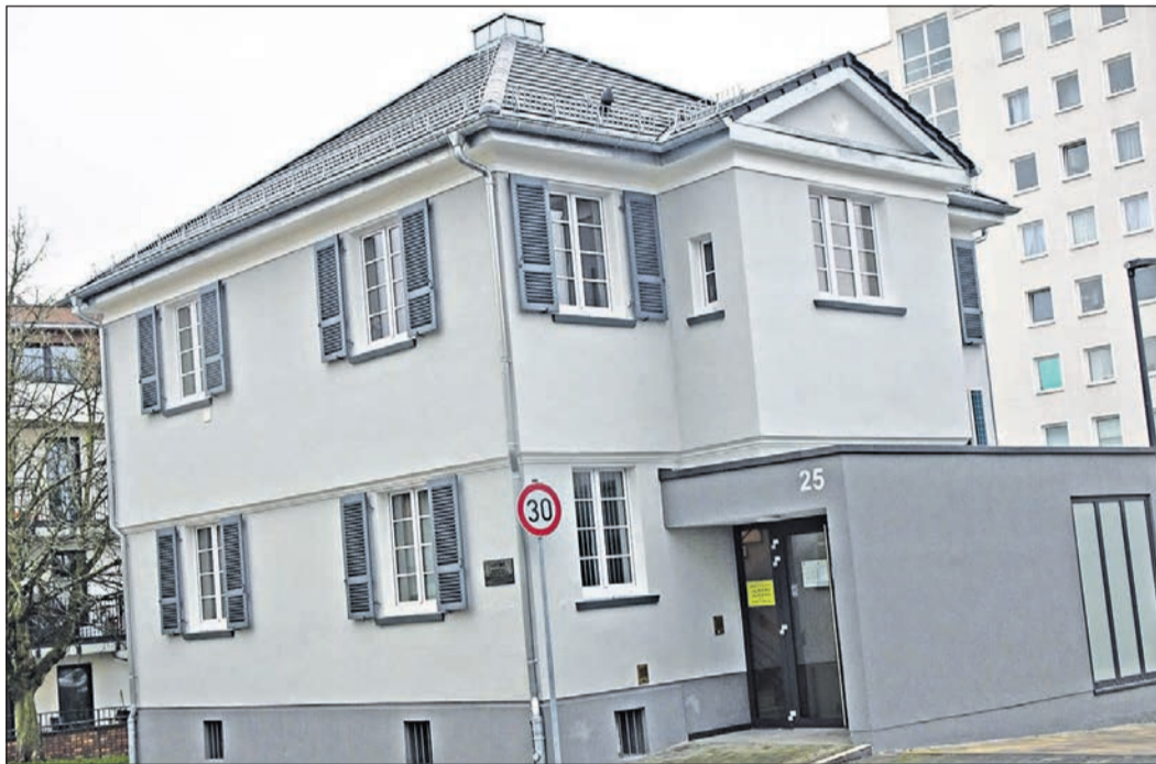
Aus der alten Villa in der Gartenstraße 25 ist nach der Sanierung ein echtes Schmuckstück geworden. Hier arbeitet Bauamtsleiter Alexander Müller mit seinem Team. Foto: HB
