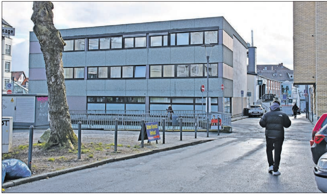
Das Commerzbankgebäude verschwindet ebenso wie die Häuserzeile links in der Holzweg-Passage. Die Tiefgarageneinfahrt, von der hier nur das Geländer zu sehen ist, wird in die Neubebauung integriert, der Chopin-Platz wird vergrößert und neu gestaltet. Foto: ach
