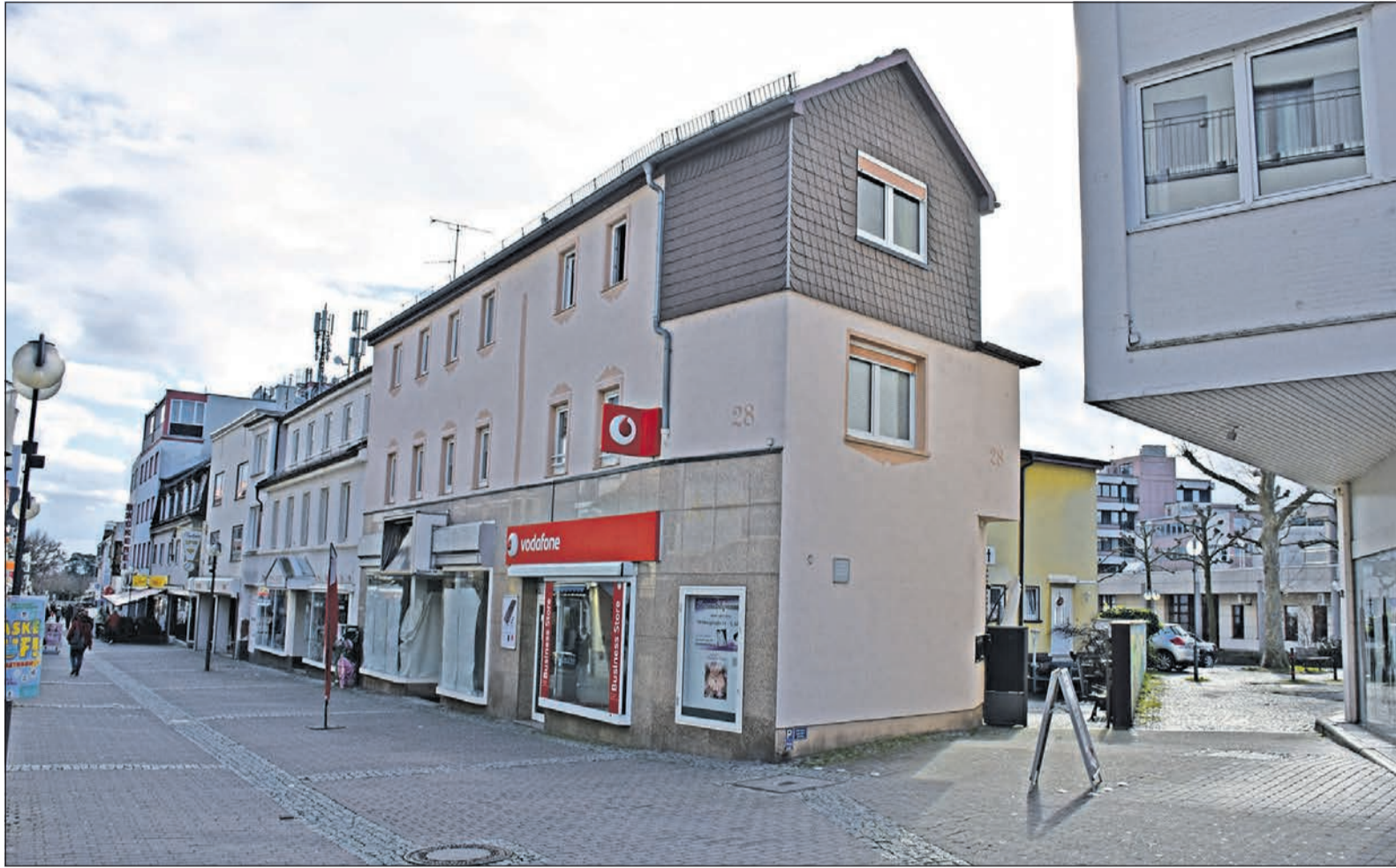
In wenigen Wochen beginnen in der Vorstadt 26 und 28 die Abrissarbeiten. Neue Wohn- und Geschäftshäuser mit zwei Läden zur Vorstadt hin und einem Café mit Außenbewirtschaftung „im Schlenker“ zur Stadthalle sollen entstehen. Foto: ach
