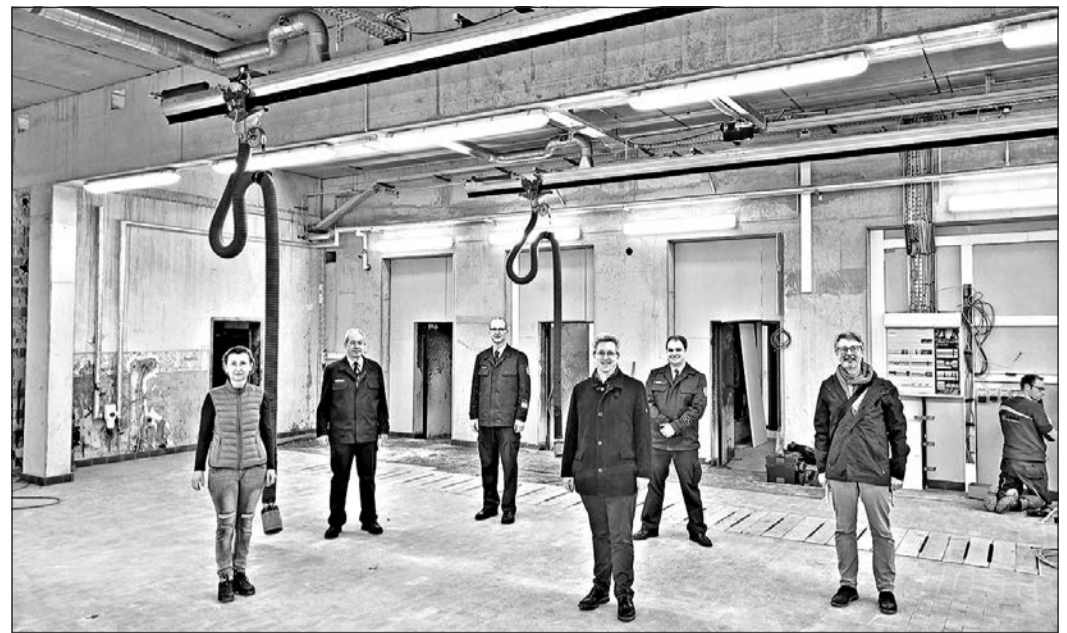
Baustellenbesuch bei der Feuerwehr Weißkirchen (v. l.): Nathalie Peters (BSO, Projektbetreuung), stellvertretender Wehrführer Nikolaus Hieronymi, Wehrführer Andreas Henzler, Erster Stadtrat Christof Fink, Stadtbrandinspektor Valentin Reuter und Bauleiter Ernst Meyer, Architekturbüro LMG. Foto: Stadt Oberursel
