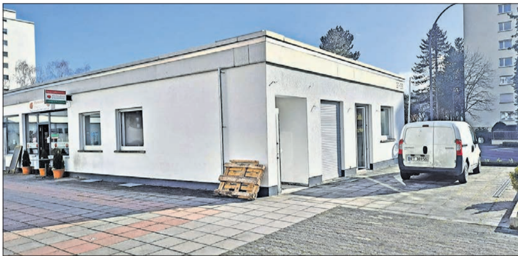
Derzeit wird der ehemalige Kirchenladen zu einer Zahnarztpraxis umgebaut.
