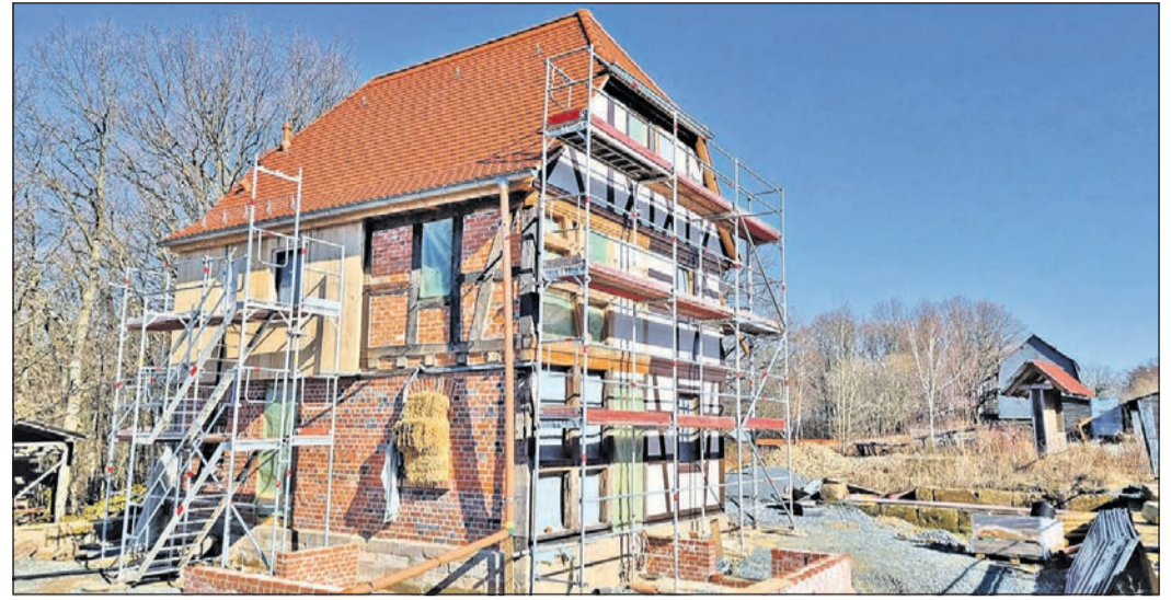
Das Fachwerk-Musterhaus aus Radheim zeigt eine sorgsam restaurierte Holzkonstruktion mit zeittypischen Zierformen und unterschiedlichen Ausfachungsmaterialien. Foto: Leon Mathieu
