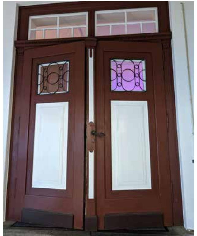
Die Eingangstür sieht noch genauso aus wie früher (im Hintergrund auf dem historischen Foto unten gut zu erkennen).
