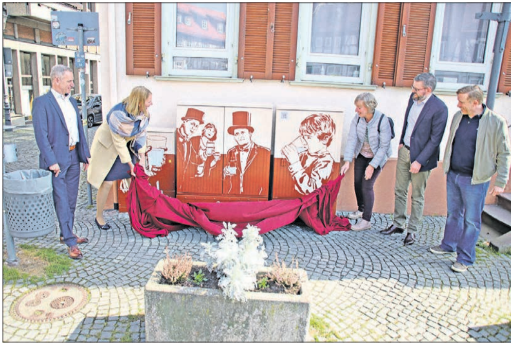
Thomas Fösel hat die künstlerische Gestaltung der drei Stromverteilerkästen beauftragt, die Antje Runge zusammen mit Edeltraud Lintelow im Beisein von Tobias Zimmermann, enthüllt. Jan-Malte Strijek (v. l.) hat das Kunstwerk geschaffen. Foto: Ehmler
