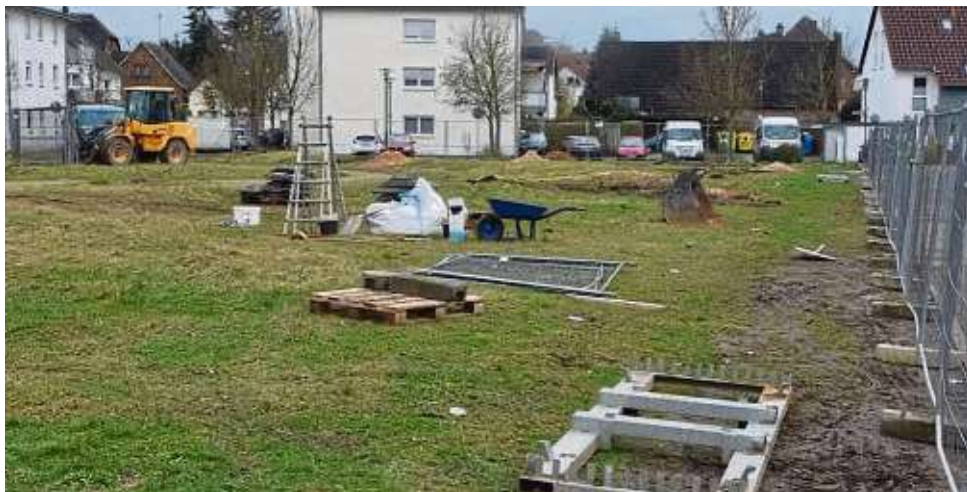
Die Baustelle für das Alten- und Pflegeheim auf dem Gelände Im Mühlfeld wird eingerichtet. In etwa einer Woche sollen die Bagger anrücken. FOTO: HOLGER HACKENDAHL
