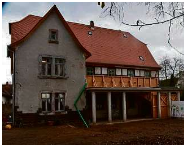
Montessori-Schule und Kinderhaus haben im Sommer 2021 im frisch renovierten alten Pfarrhaus in Großauheim eröffnet.
