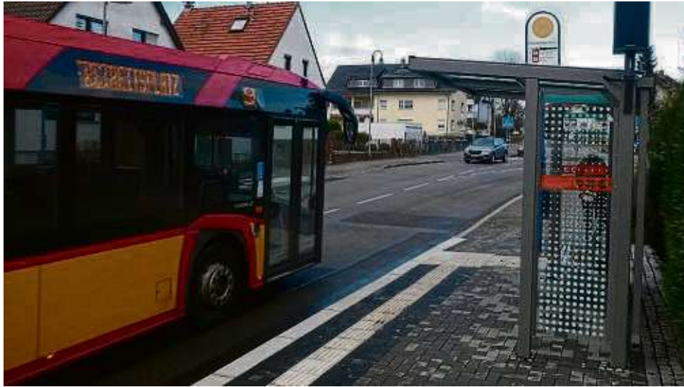
Wie an der Kilianstädter Straße sorgen in Mittelbuchen jetzt insgesamt acht neue Wartehallen für mehr Fahrgast-Komfort.
