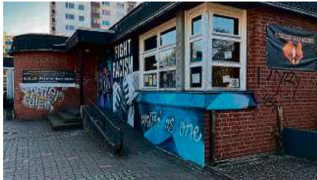
Langfristig soll das Gebäude des JUZ Kesselstadt abgerissen und an anderer Stelle neu gebaut werden. FOTO: PM
