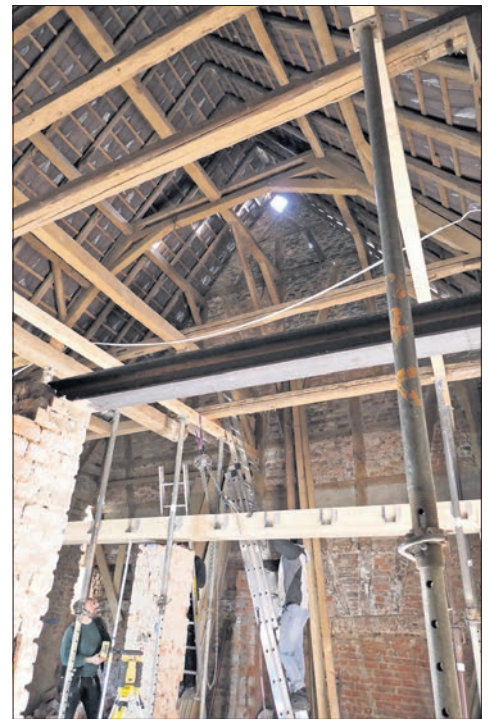
Eine Scheune in der Untergasse wird saniert und zum Wohnhaus ausgebaut. Foto: bpa
