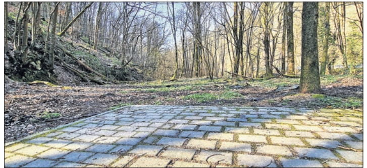
Blick von der Straße Am Herrngarten in den Wald in Richtung Bremthal. An dieser Stelle endet aktuell der Weg. Foto: Stadt Eppstein.
