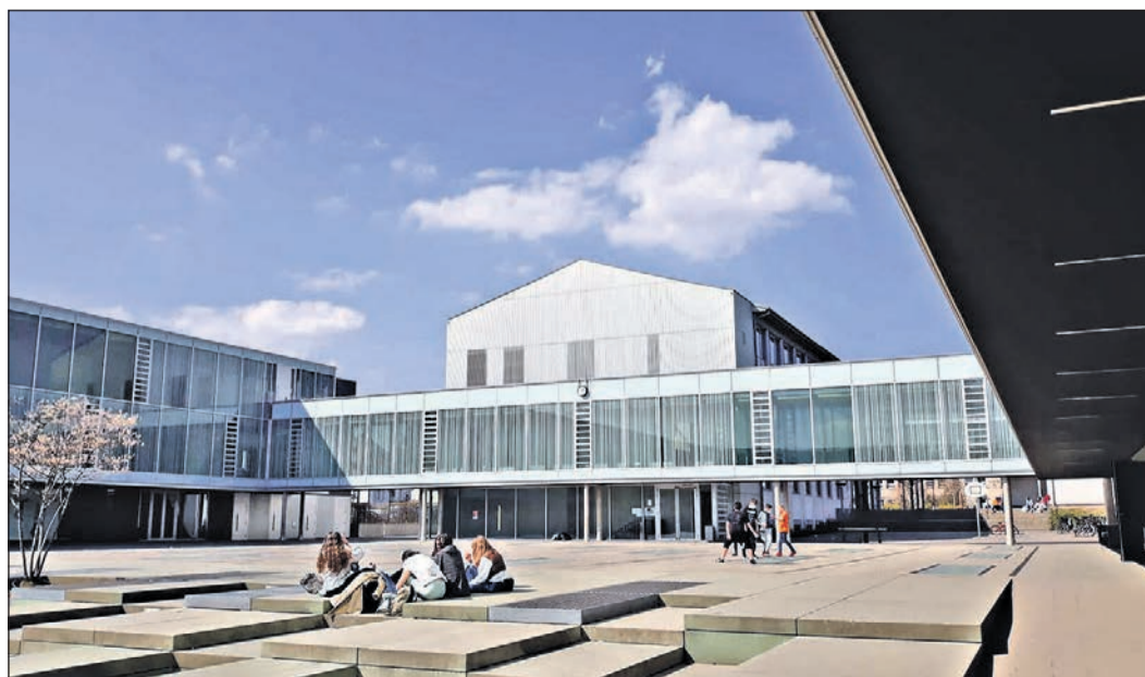
Die Erweiterung des Gymnasiums Oberursel wurde zum 60-Millionen-Euro-Projekt. Foto: js
